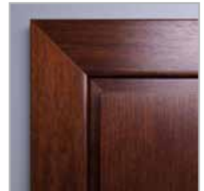
łączenie opasek pod kątem 45°
